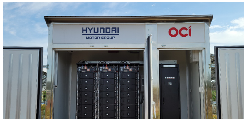
현대자동차 재사용배터리 ESS / 307.36 kWh
