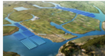
해장만 수상태양광 98MW
