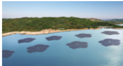
한국수력원자력·한국수자원공사 임하댐 수상태양광 47MW
